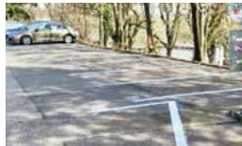
Nové vodorovné dopravné značenie.
